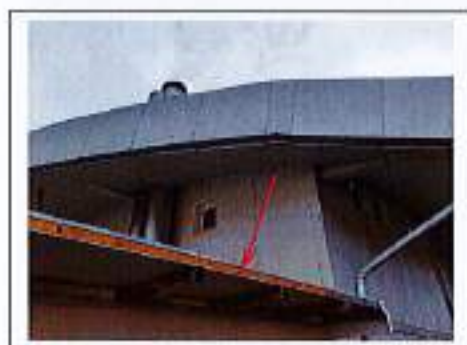
Fig. 45 – Acoperisul corpului de legatura - et.3- corp B
