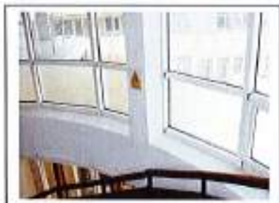
Fig. 37 – Detaliu cu ferestrele tangente zonei scări (corp B)
