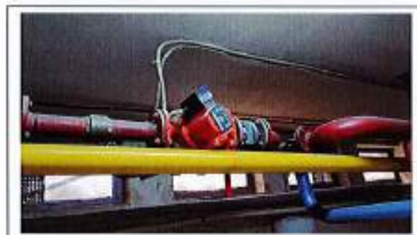
Fig. 49 - Pompele pentru circulația agentului termic în cele 2 corpuri de clădire (Salmson și DAB)
