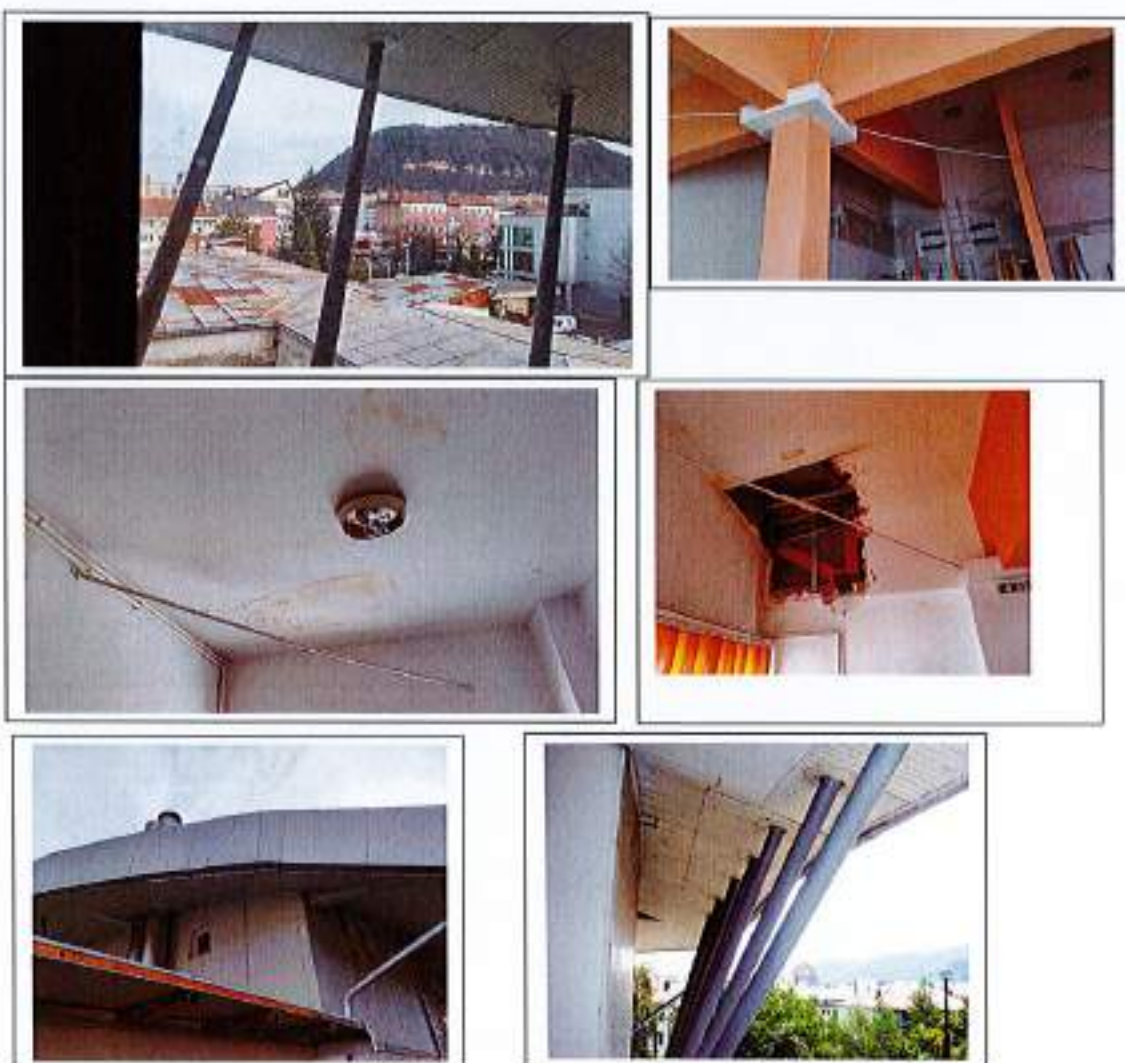
Fig. 41- Detaliu al sarpantei și al sistemul de sprijin al acoperisului (tevi, tiranti)
