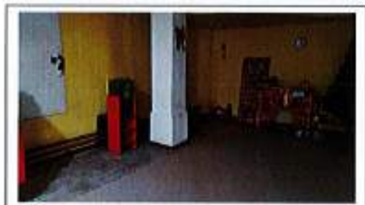
Fig. 53 Conducte de distributie in camere incalzite (subsol corp A)
