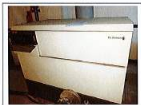
Fig. 47 - Cazanele de pardoseala De Detrich, fiecare cu puterea de 280[kw] - subsol Corp
