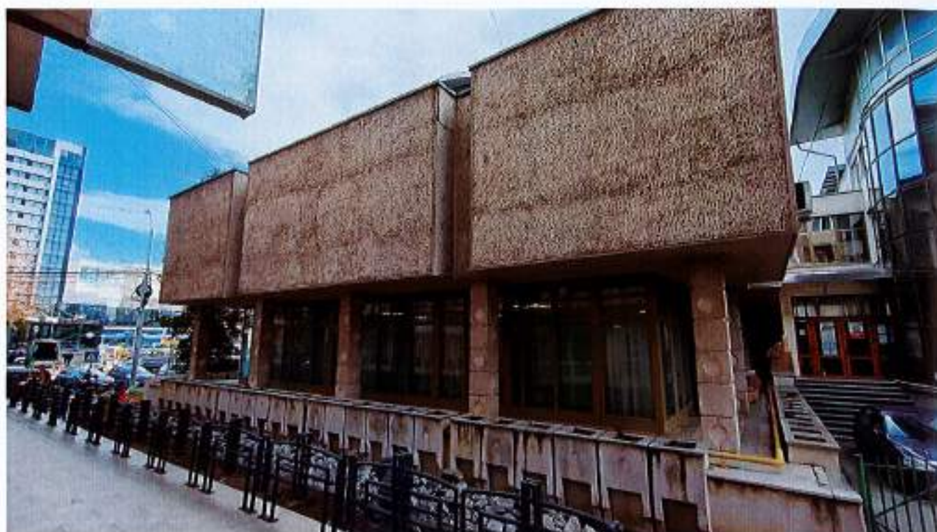
Foto 3. Fațadă laterală dreapta
