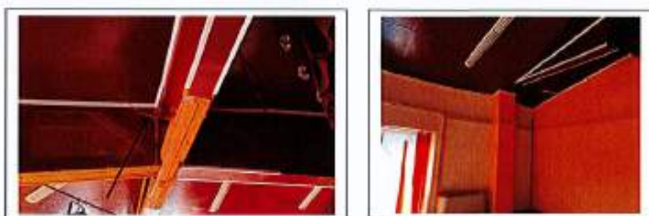
Fig. 40 - Protecția tavanelor cu tabla perforata - et.3- corp B
