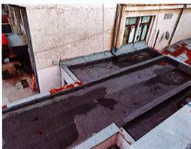
Foto 9. Terasa și cupolă Corp A
