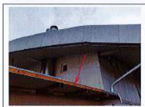
Fig. 45 – Acoperisul corpului de legatura - et.3- corp B
