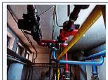
Fig. 49 - Pompele pentru circulația agentului termic în cele 2 corpuri de clădire (Salmson și DAB)
