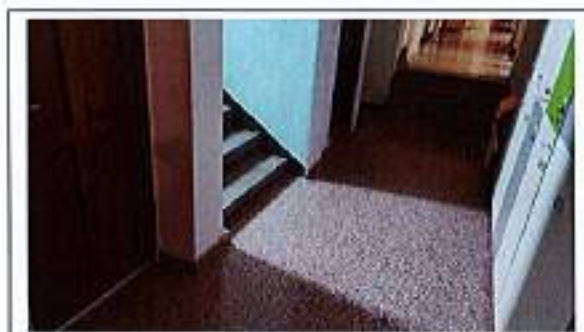
Fig.13 - Pardoseala din granit
