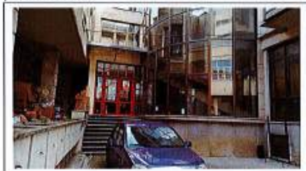
Fig. 27 – Fațada N-V – zona aferentă corpului B
