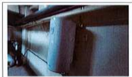
Fig. 58 - Boilerul electric pentru prepararea apei calde menajere
