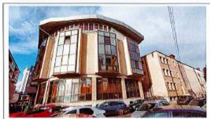
Fig. 31 – Fatada S-E si partial S-V – zona aferenta corpului B
