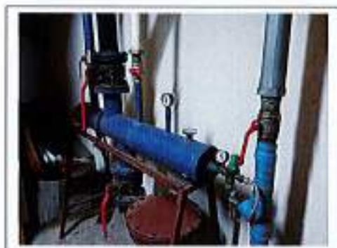
Fig.48 - Colectorul de retur
