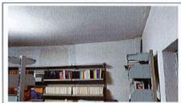
Fig. 46- Detaliu interior, la etajul 3 – corp B
